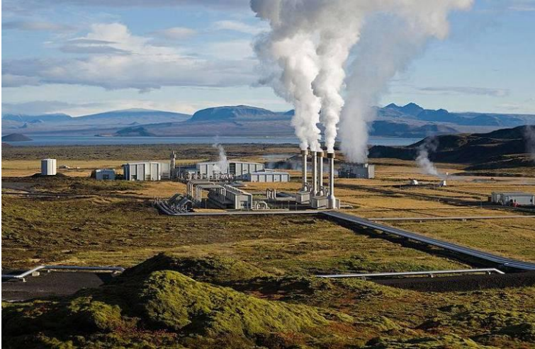
La stazione geotermica di Nesjavellir fornisce energia alla zona di Reykjavík
