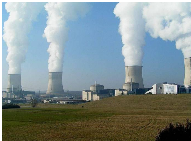
La centrale nucleare di Cattenom nel dipartimento di Mosella
